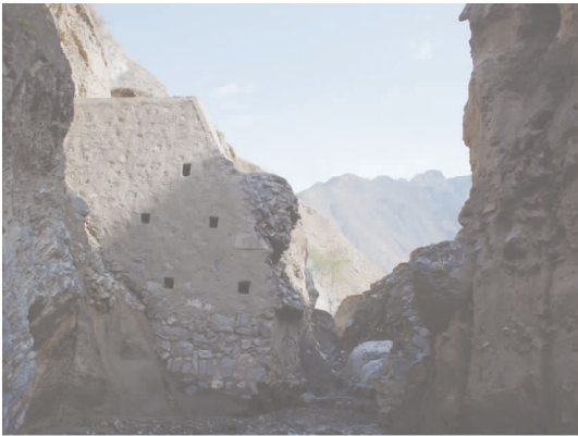
图 1 野外拦沙坝被冲毁的现象(镜头朝向上游)
